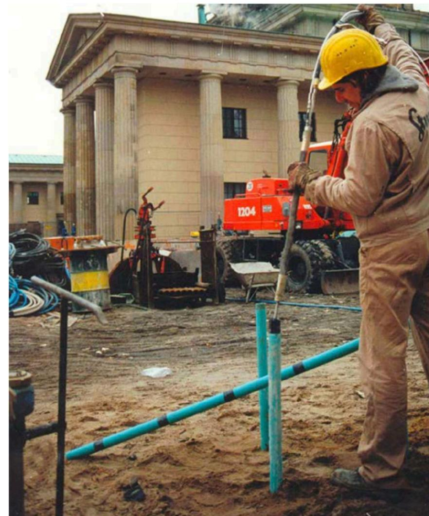
Установка двухстороннего пакера в манжетную колонну для пропитки структуры грунта инъекционными смесями на основе особо тонкодисперсных вяжущих типа Mikrodur или «Интроцем»
